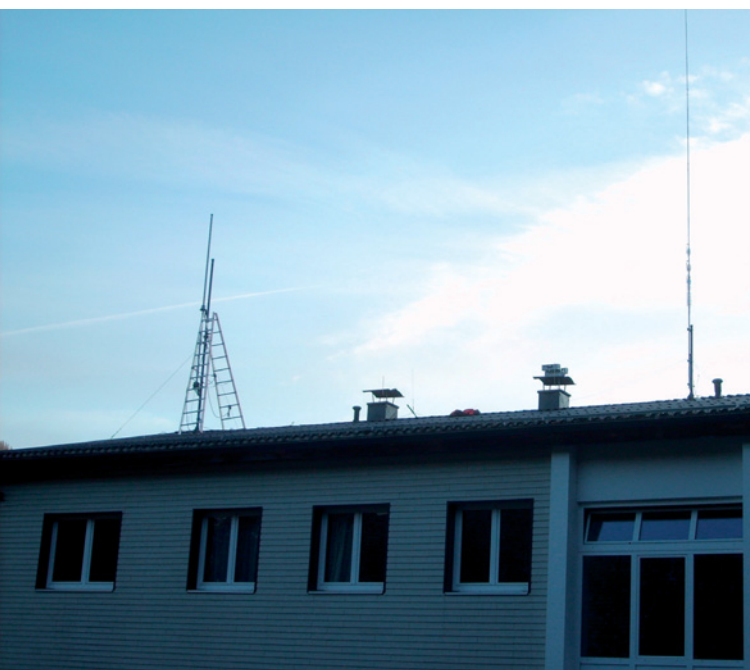
Antennenaufbau am Internatsgebäude
