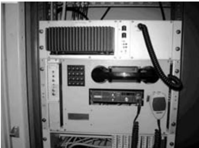
*70-cm-Relais EMD850 mit Remote TRX EM850 und PONCOM Steuerung*
